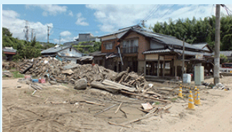
家屋1階部分が流失
