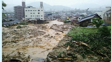
押し流され、倒壊する家屋(写真は広島市安佐北区口田南地区=7日撮影)
